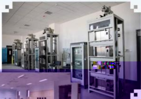
智能电梯安装调试 维护训练场所
